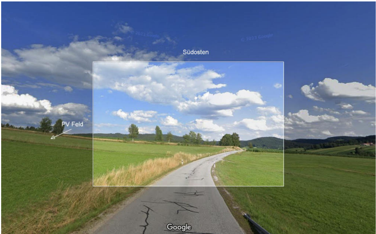
Bild 4.1.2: Foto am Messpunkt P1, Fahrt Richtung Südosten (Quelle: Google StreetView, Juli 2022, Ausschnitt)
